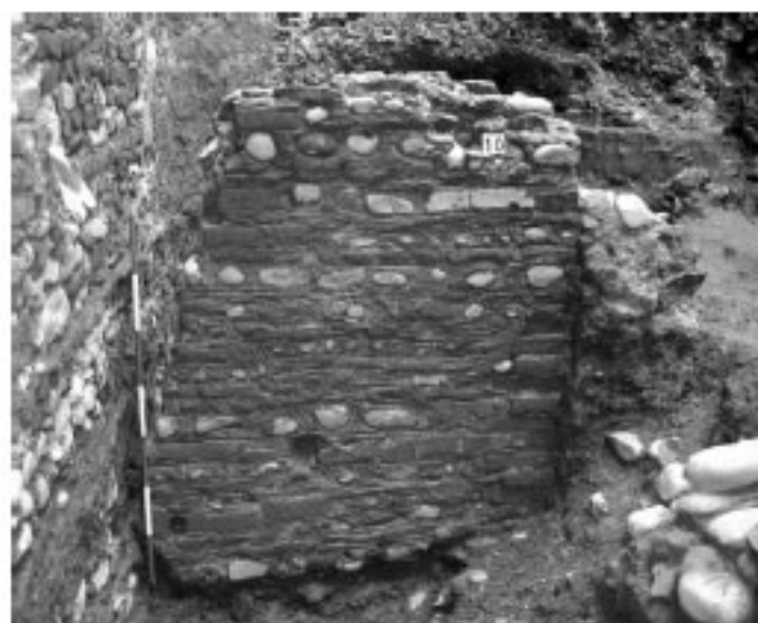
Fig. 178. Torino, via Barbaroux 27. Vano riscaldato sud-est: particolare della tecnica muraria.
