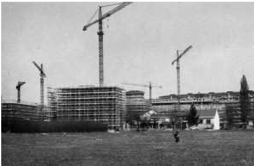
Il quartiere Mirafiori sud in costruzione
